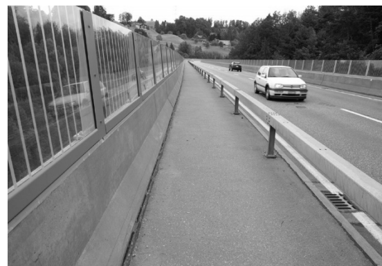
Fig. 7.3 Parapet de sécurité surmonté d'une paroi transparente avec des bandes gravées pour la protection des oiseaux.
